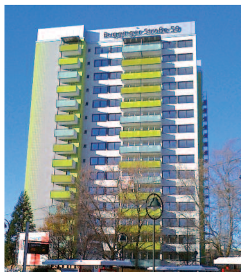
Deutschlands erstes Passivhochhaus: Die Bugginger Straße 50 in Weingarten
